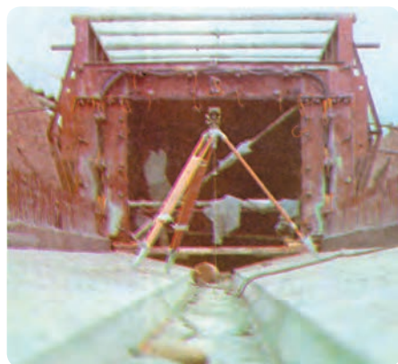
شکل ۳۰-۸- دوربین تراز یاب، سانتراژ با شاقول
