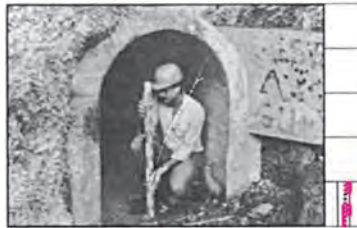
شکل ۱۴-۸- طریقه‌ی نگاه داشتن میر
